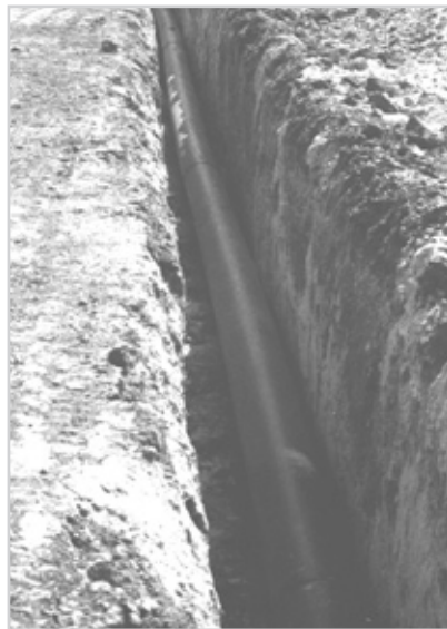
53. ábra: Csőfektetés: a cső aszimmetrikus árokba helyezésével nem érhető el megfelelő beágyazás!
