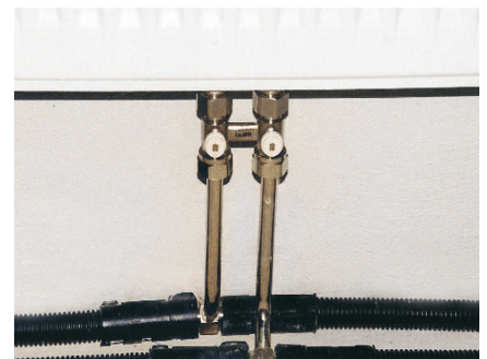
Csatlakozás radiátor bekötő T-idommal
