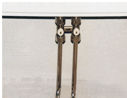
Csatlakozás radiátor bekötőívvel
